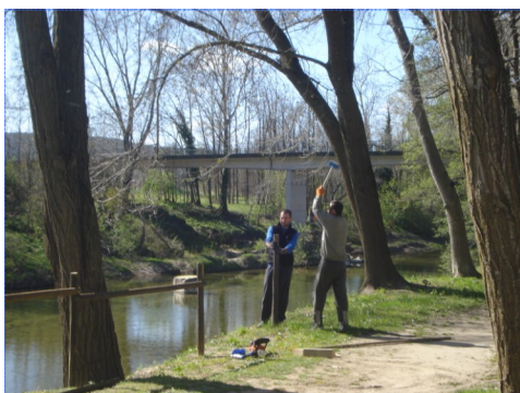
La pose des rambardes
