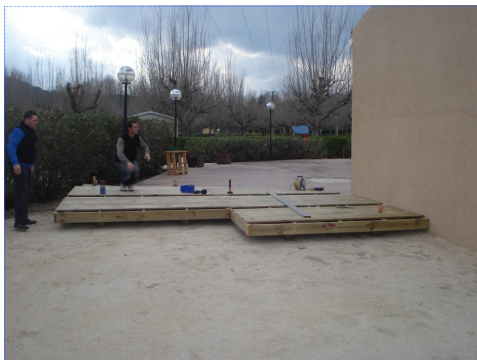
Le plancher en cour de réalisation
