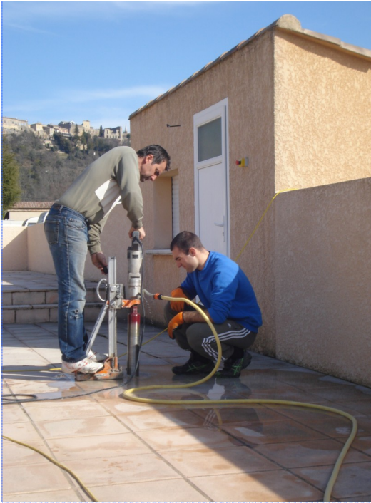
Le carottage en cours
